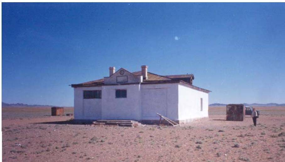
Foto 12: Ehemaliges Brigad - Zentrum des Tawan Tolgoi- Brigad , wird jetzt als Kaschmirsortieranlage genutzt
