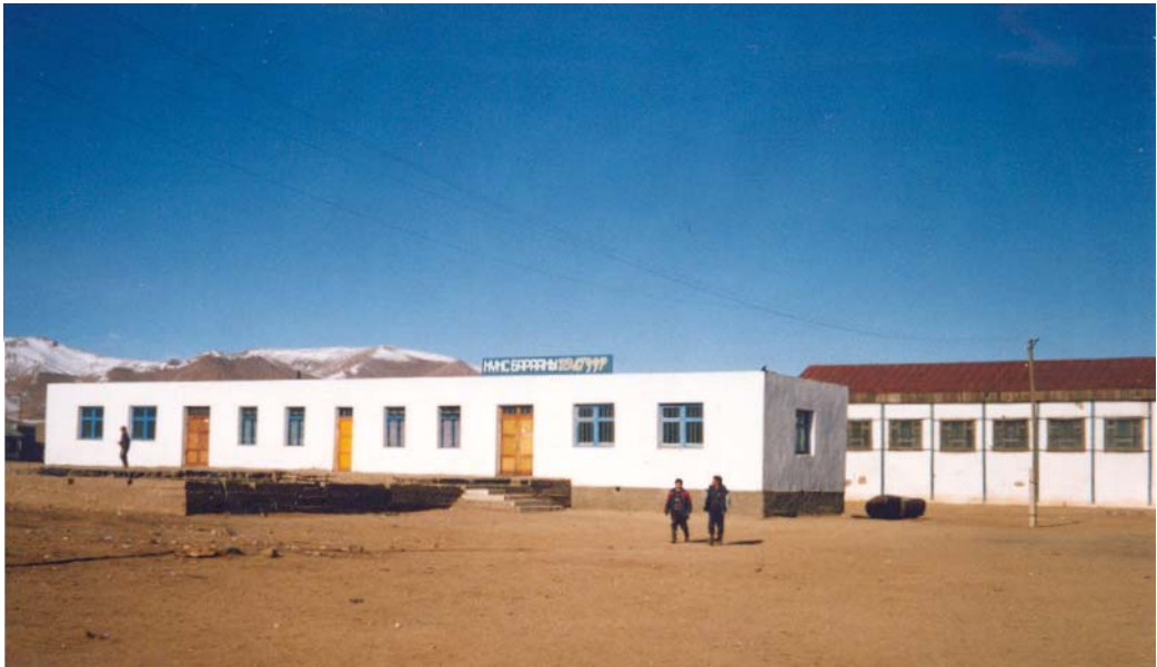
Foto 15: Fertiggestelltes Gebäude, jetzt in Nutzung der drei Genossenschaften „Olonlog“, „Oroin Tschimeg“, „Ich Maltschin Bulag“
